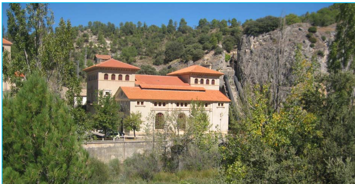
Central Hidroeléctrica de Villalba-La Toba (Villalba de la Sierra)
