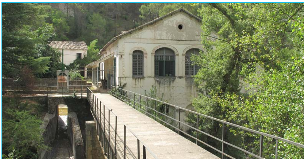
Central Hidroeléctrica de las Grajas (Cuenca)
