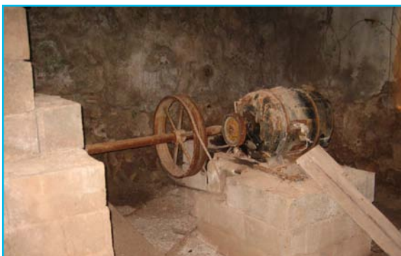
Generador del Molino de Huélamo (Huélamo)
